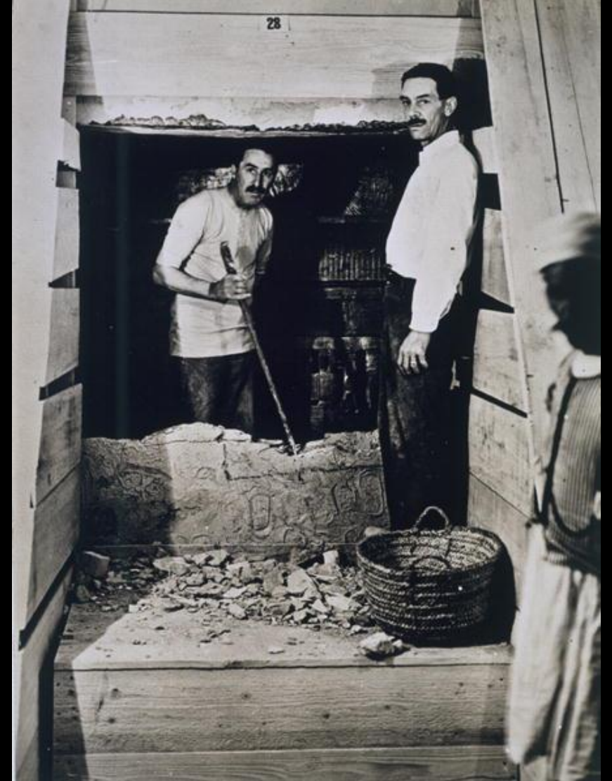
Howard Carter y uno de sus ayudantes junto a un muro parcialmente demolido de la tumba
